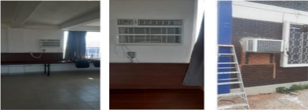
**Figura 85.** Instalación de aires acondicionados tipo ventana.
