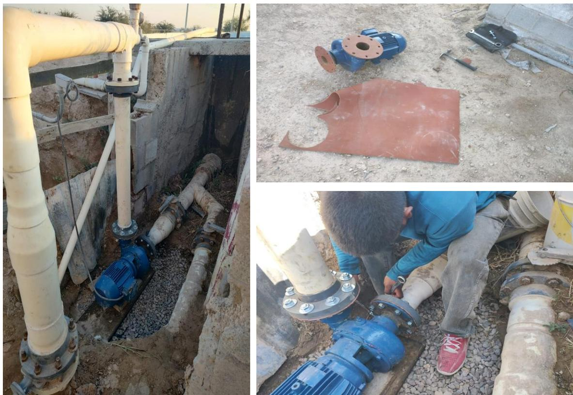
**Figura 59.** Reparación de bomba para riego agrícola
