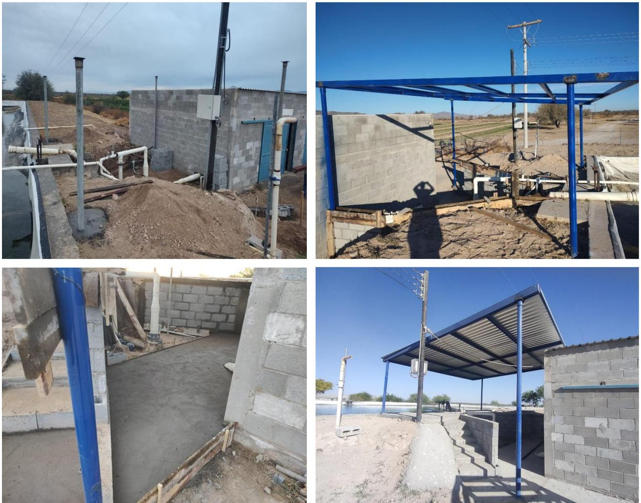
**Figura 60.** Instalación de techumbre para protección de la bomba de riego
